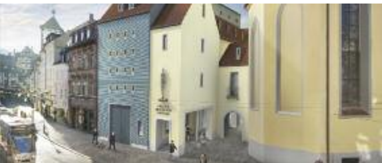
oben: 2. Bauabschnitt des Augustiner museums, Entwurf Architekturbüro Prof. Mäckler, Visualisierung M. Dold GD 90 rechts: Vorbereitungen für den 2. Bauabschnitt, Foto: Museum
