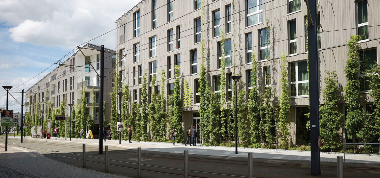
Abb. 179: Stadthaus M1, Freiburg (Foto: © Jakob AG)
