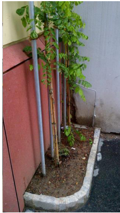
Abb. 199–201: Pflanzgrube mit wurzelfester Betonumrandung, Ortlieb­gasse 17, Wien (Fotos. Jürgen Preiss)
