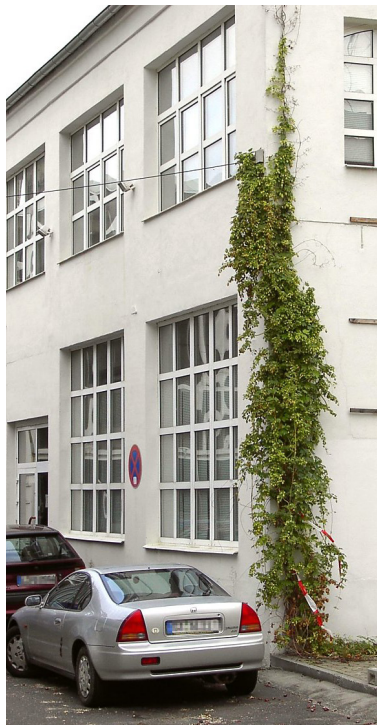
Abb. 189: Mit Hopfen begrüntes Regenfallrohr (Foto: © fassadengruen.de)
