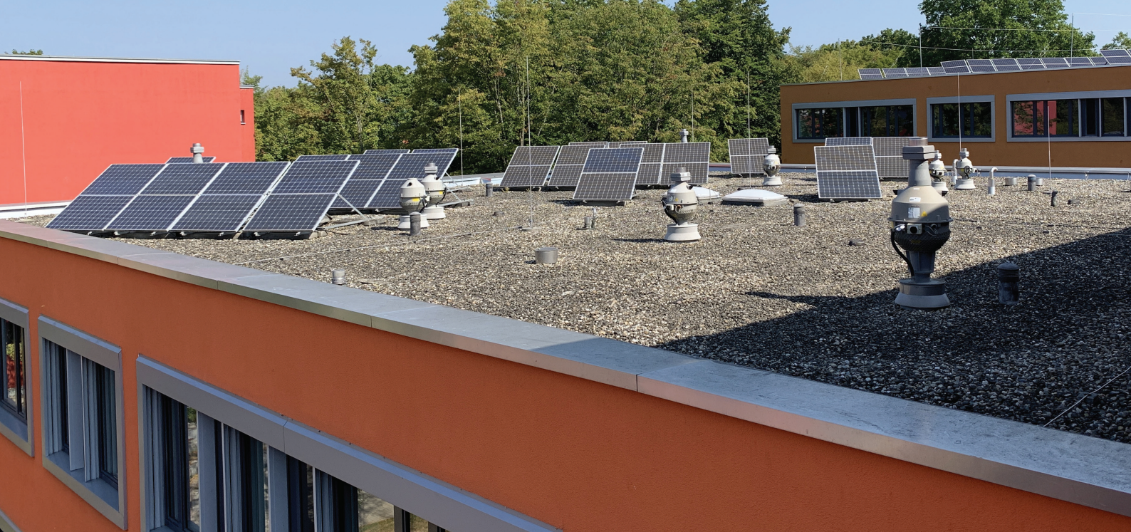
Abb. 228: Bestehendes Kiesdach mit Photovoltaik-Anlage (Foto/Darstellung: © Vertiko GmbH)
