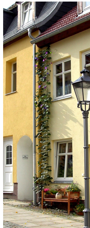
Abb. 206: Einjährige Prunkwinde an vertikalen Drahtseilen (© fassadengruen.de)
