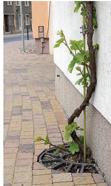
Abb. 197: Einschnitt in Verbundpflaster, Distanzgitter aus Gusseisen. (Foto: © fassadengruen.de)
