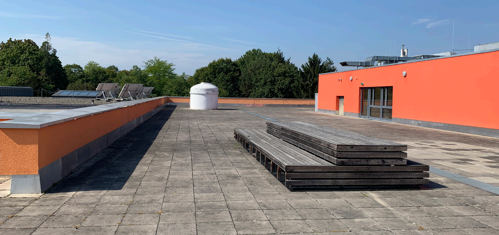
Abb. 225: Bestehender Dach-Schulhof mit Beton-Plattenbelag (Foto/Darstellung: © Vertiko GmbH)
