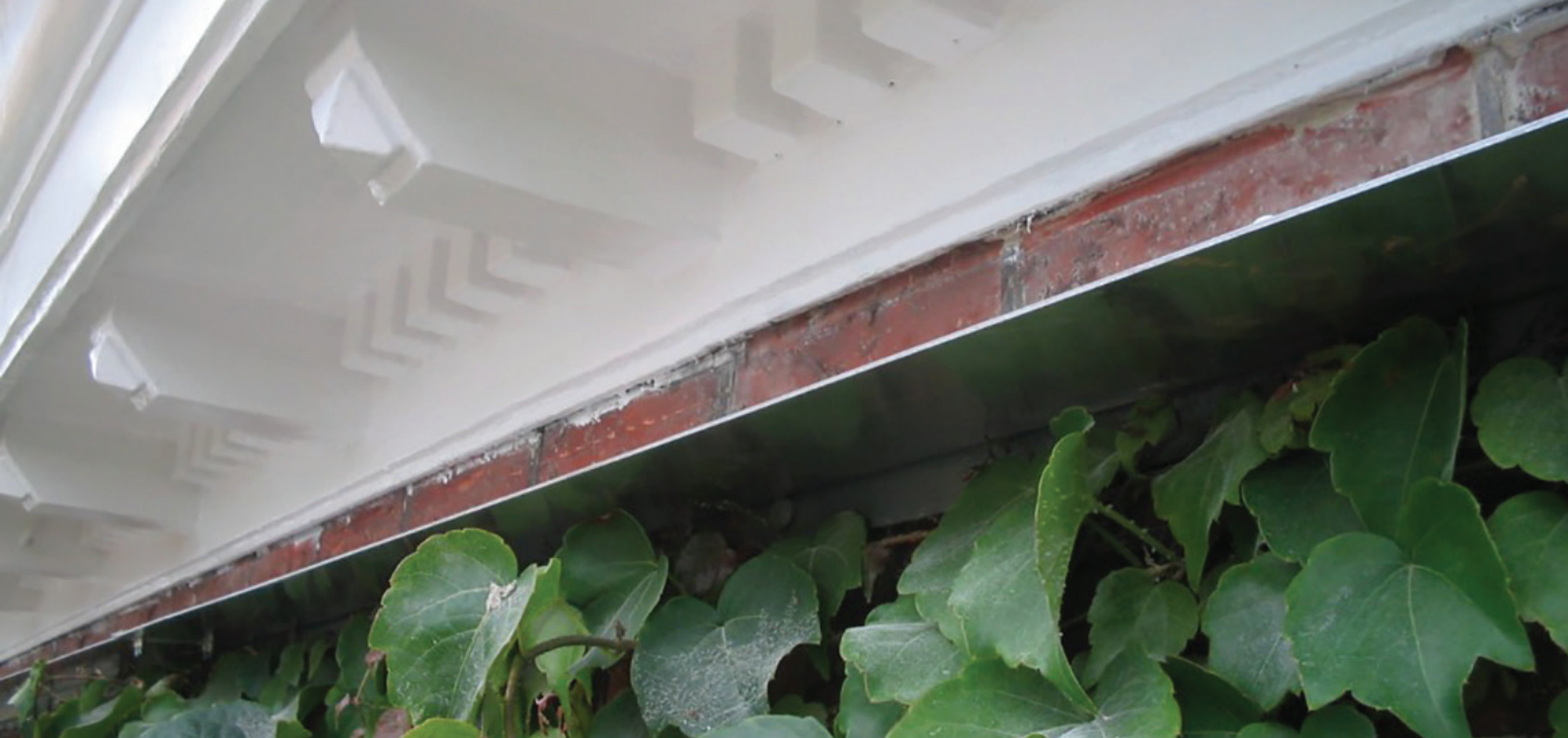
Abb. 175: Aluminiumprofil mit elektrischer Spannung als Wuchsbegrenzung (© GG Green, Peter Boogaerts)
