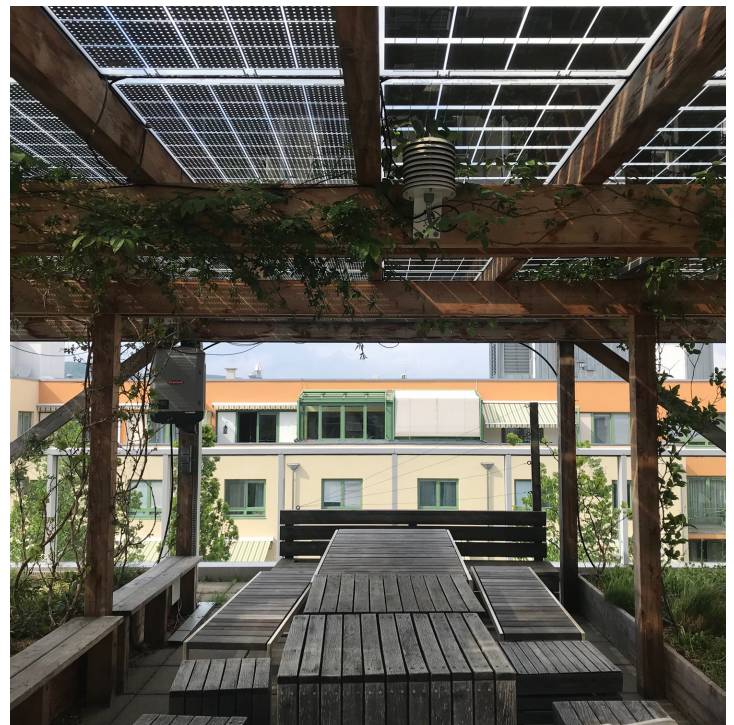
Abb. 159: Photovoltaik-Dachgarten: Versuchsanlage, BOKU Wien
