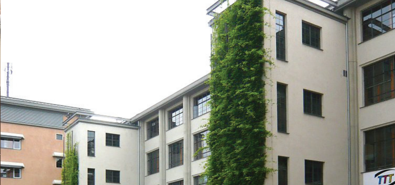
Abb. 211: Vertikalbegrünung mit Wisteria an einem Gewerbebau in Dresden (Foto: © fassadengruen.de)
