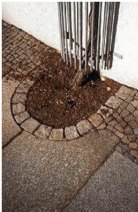
Abb. 196: Pflanzring mit Schnitt in Granitkrustenplatten, Stabgitter zum Schutz des Haupttriebs (Foto: © fassadengruen.de)
