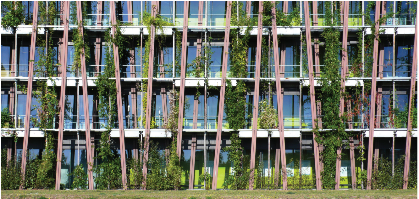
Abb. 79: Wandgebundene Begrünung mit Gerüstklet- pflanzen. Fassadenausschnitt Physikgebäude der Humboldt- Universität, Berlin-Adlershof (Foto: Nicole Pfoser 2011)
