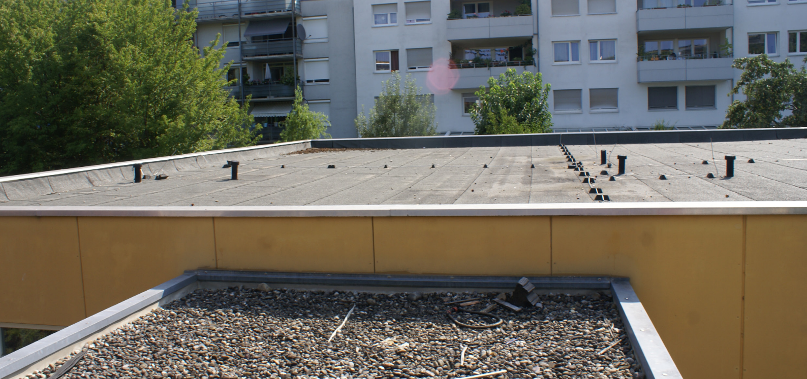
Abb. 145: Dach KiTa Rieselfeld (© Vertiko)
