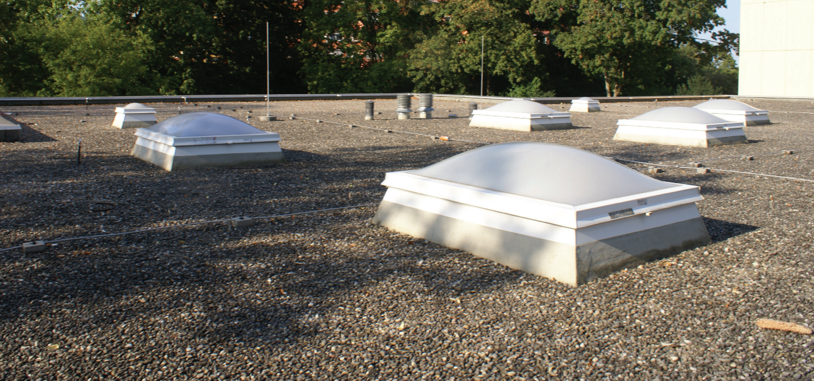
Abb. 233: Bestehendes Kiesdach (Foto/Darstellung, oben: © Vertiko GmbH; rechts: © Pfoser)
