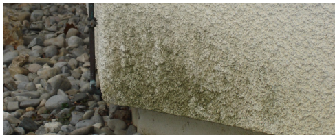
Algen und Pilze an einer Hausfassade Foto: © H. Bartholemy/ Bundesverband Farbe Gestaltung Bautenschutz
