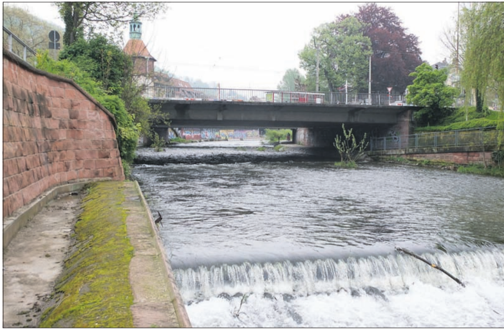
Ein Teil des Weges ist schon da: Auf der Dreisamnordseite soll unterhalb der Schwabentorbrücke die letzte Lücke geschlossen werden. Beim Bau der neuen Stützmauer (links) wurde der künftige Fußweg schon mit eingeplant. (Foto: A. J. Schmidt)
