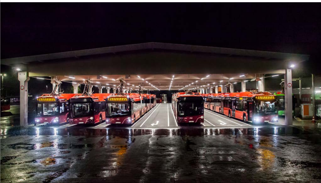
Halle für E-Busse am Betriebshof © AnjaThölking
