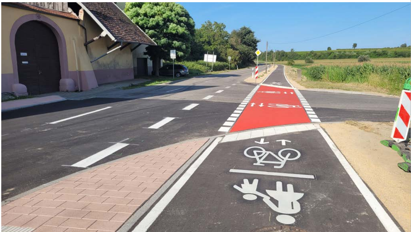
Neu gebauter Fuß- und Radweg Merdingen – Waltershofen
