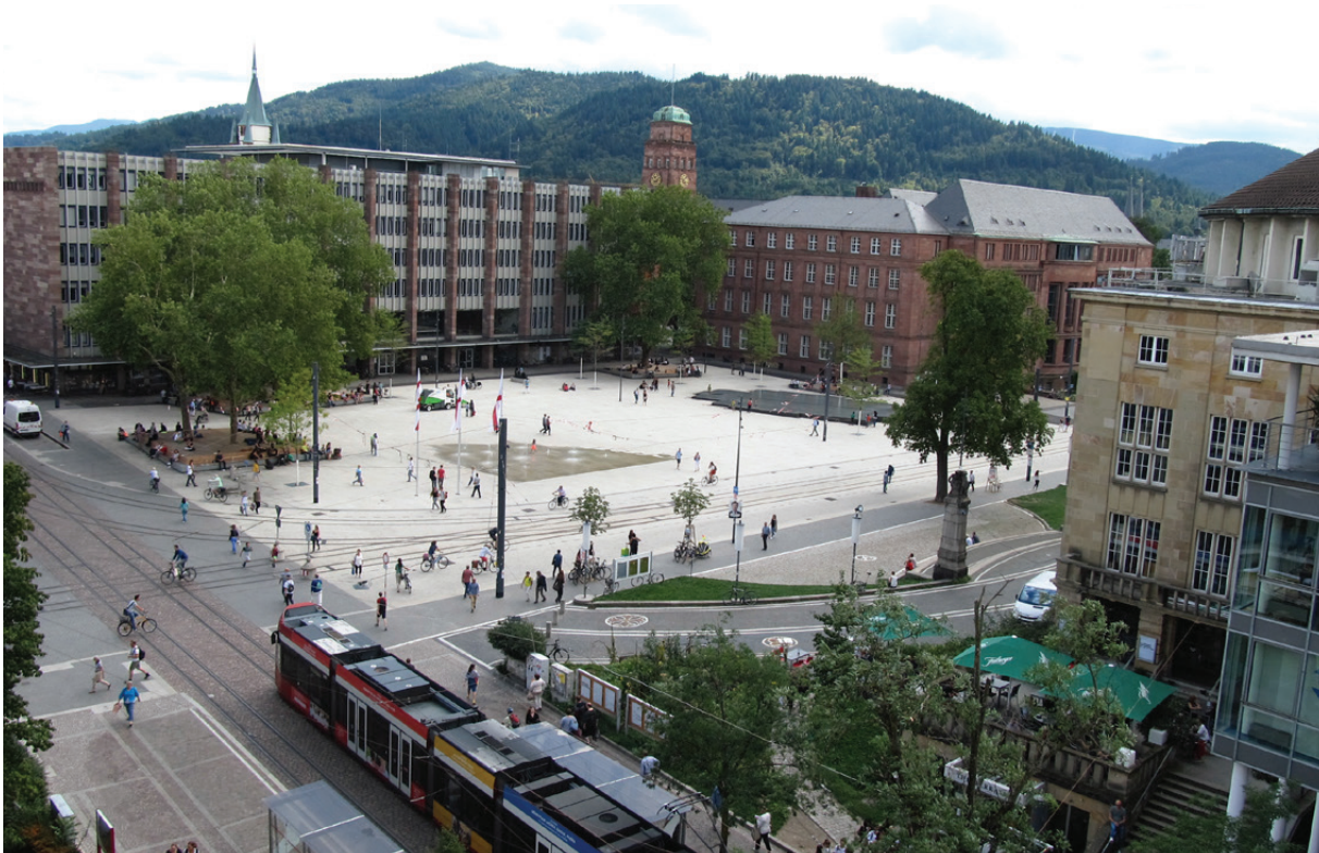
Oberfläche mit hoher Albedo auf dem Platz der Alten Synagoge in Freiburg
