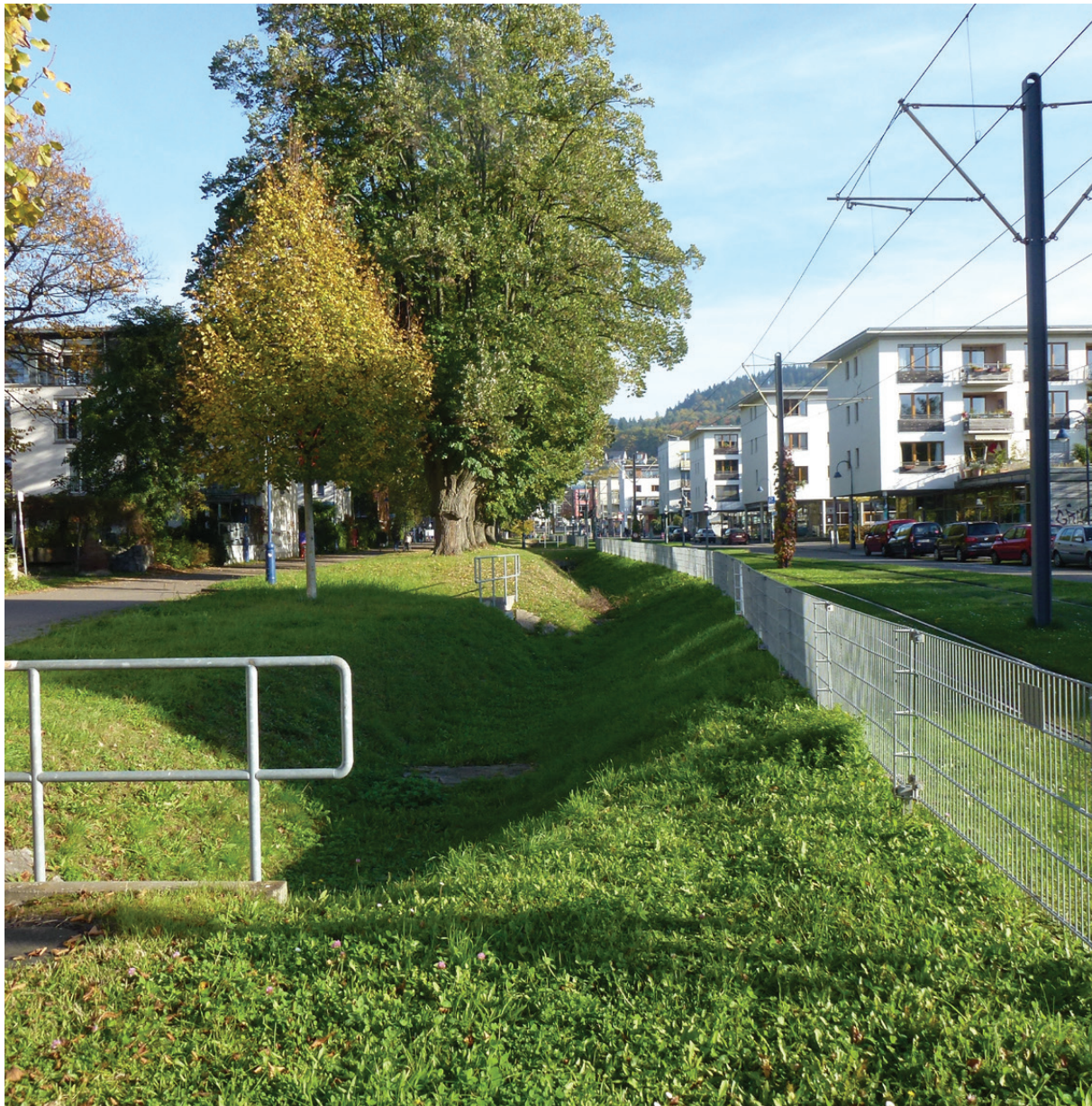
Muldenversickerung in dem Stadtteil Vauban
