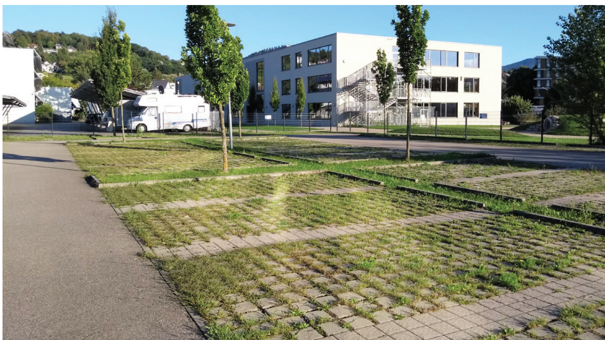
Umgestaltung eines Parkplatzes mit Rasengittersteinen und Baumpflanzung in dem Gewerbegebiet Unterwihre
