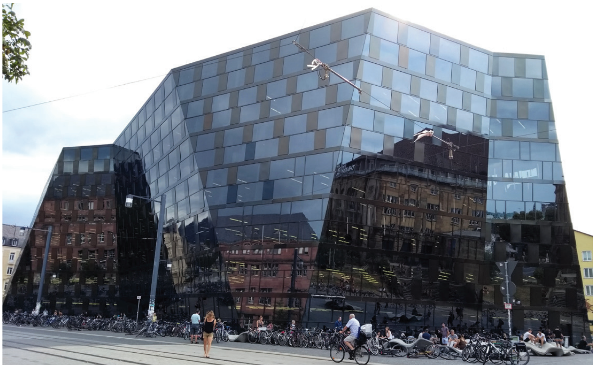
Die Freiburger Universitätsbibliothek verfügt über ein Heiz- & Kühlsystem mittels Betonkerntemperierung
