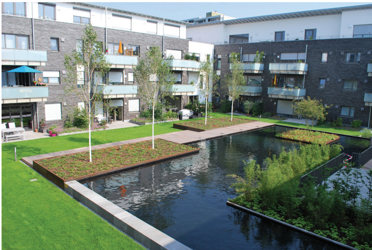
Tiefgarage mit Gartendach in Kaarst
