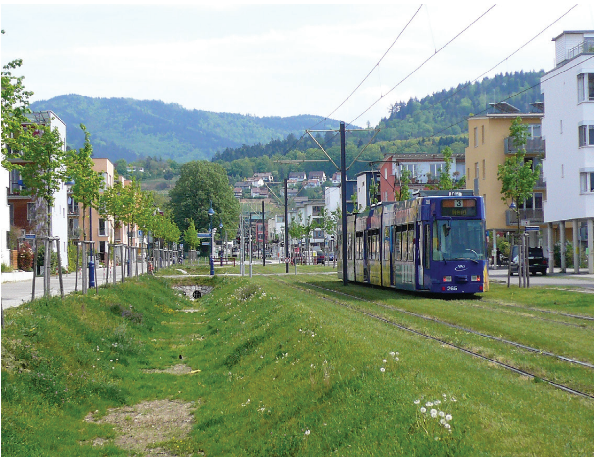
Muldenversickerung in dem Stadtteil Vauban
