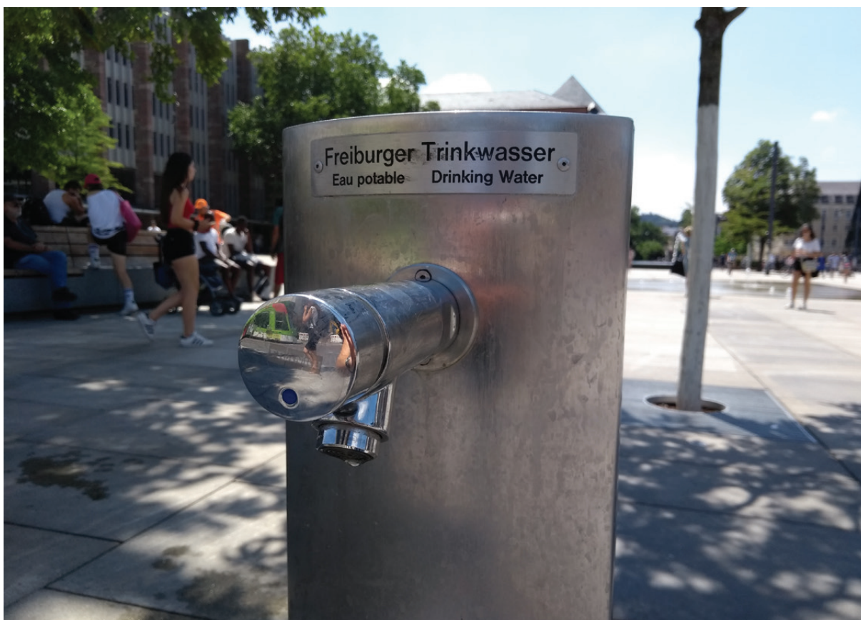
Trinkwasserbrunnen auf dem Platz der Alten Synagoge in Freiburg
