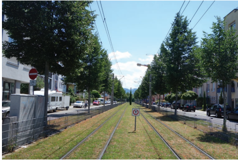
Hauptverkehrsstraße mit Stadtbahn Rieselfeld
