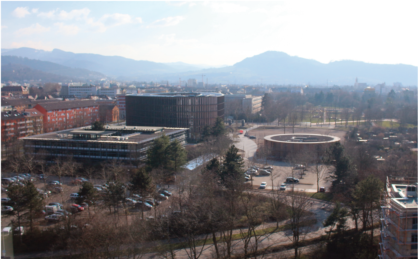
→ Blick nach Süden mit Anschluss an Eschholzpark
