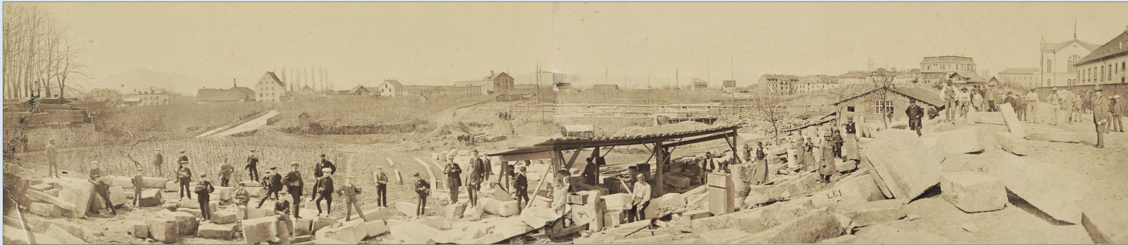
Baustelle der Bürgerschule (später Rotteck-Gymnasium): Diese sogenannte Panoramaaufnahme zeigt die Baustelle der Bürgerschule und des späteren Rotteck-Gymnasiums. Die Grundmauern der Schule auf dem ehemaligen Festungsgürtel sind bereits fertiggestellt. Dahinter stehen nur einzelne Häuser und Höfe; außerdem ist am rechten Bildrand die alte Synagoge zu sehen. Außerdem gibt die Fotografie Aufschluss über zeitgenössische Arbeitsweisen: aufmerksame Betrachter und Betrachterinnen können erahnen, welche Anstrengungen es erforderte große Steine zu bewegen. Gottlieb Theodor Hase visualisierte somit nicht nur den Wandel des Stadtbildes, sondern hielt mit seiner Kamera auch den technischen Ablauf auf Baustellen fest. Für Peter Kalchthaler ist diese Aufnahme ein gutes Beispiel dafür, wie die Hase-Fotografien einen „Einblick in die Arbeits- und Lebenswelt des 19. Jahrhunderts geben.“ Panoramaaufnahmen entstehen, indem zwei Fotografien aneinander gesetzt werden, für die ansonsten ein extremes Weitwinkelobjektiv oder eine bewegliche Kamera notwendig wäre. In der Mitte des Bildes die Schnittstelle zu erkennen. (Foto: G. T. Hase, 1873, Papierabzug)
