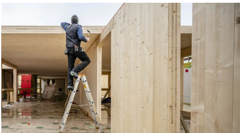
Abb. 15: Beispiel Holzbau, Errichtungsphase
