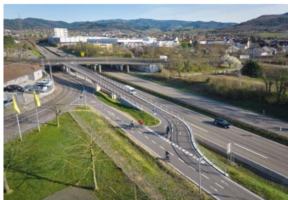
Rad- und Fußverkehrsrampe als Verbindung FR 2 und FR 6 © Ministerium für Verkehr Baden-Württemberg | Johanna Lohr | mit Hilfe von KI bearbeitet
