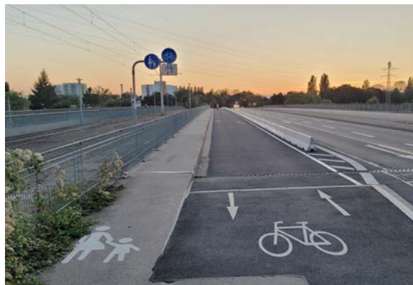
FR 5: Einrichtung eines abgetrennten Rad- und Fußwegs auf der Berliner Brücke © Stadt Freiburg
