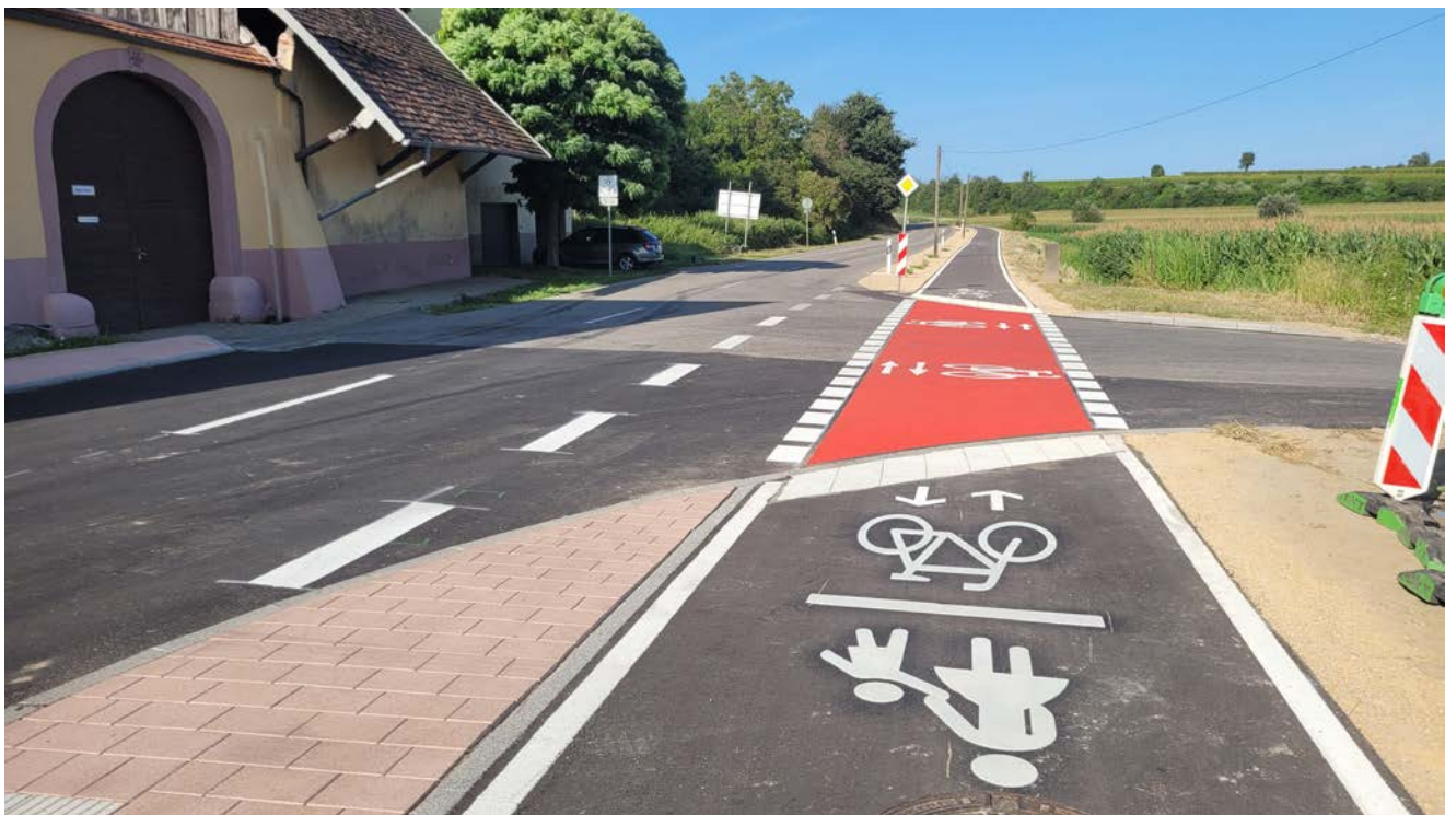
Neu gebauter Fuß- und Radweg Merdingen – Waltershofen
