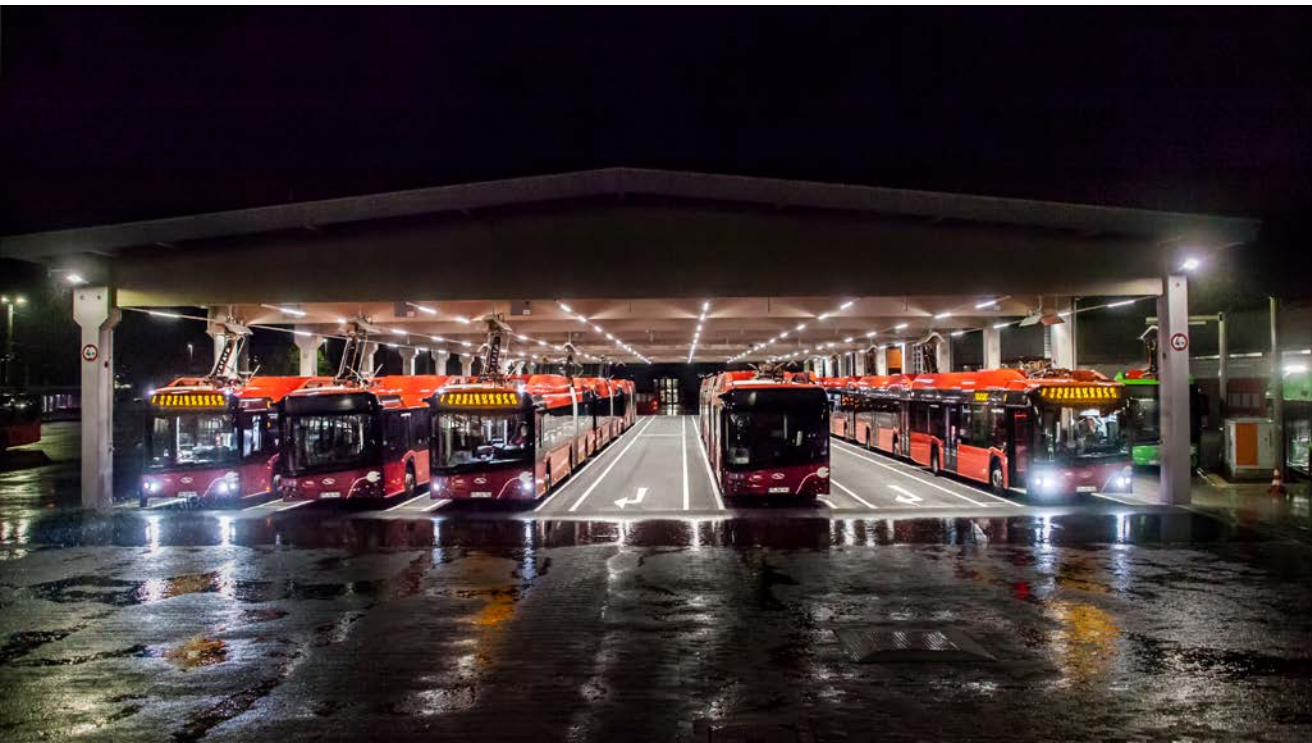
Halle für E-Busse am Betriebshof © AnjaThölking
