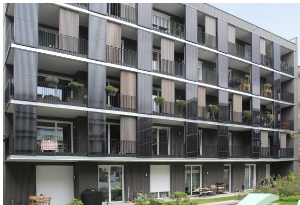
Photovoltaik an der Fassade Neckarbogen, Heilbronn
