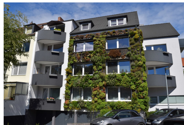
Wandgebundene Fassadenbegrünung Am Emmerberge, Hannover
