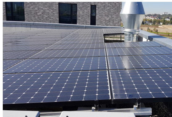
Zusammenhängende PV-Pultaufständering Neckarbogen Heilbronn
