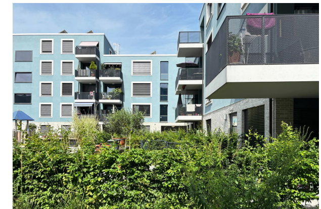
Weit auskragende Balkone in Richtung Innenhof
