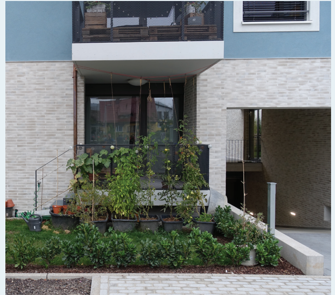
Ebenerdige private Vorzone Gutleutmatten Ost, Freiburger Stadtbau Hetzel + Ortholf Architekten, Freiburg
