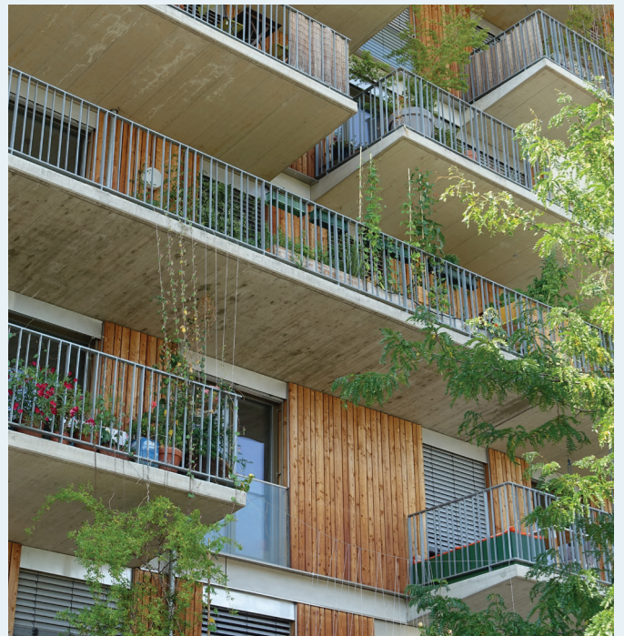
2. | 4. Vorgehängte Einzelbalkone Güterbahnhof Nord, Wien
