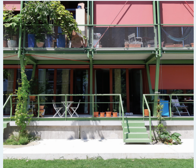
Erhöhte private Vorzone Ehem. Weinlager, Lysbüchel, Basel Esch Sintzel Architekten, Zürich
