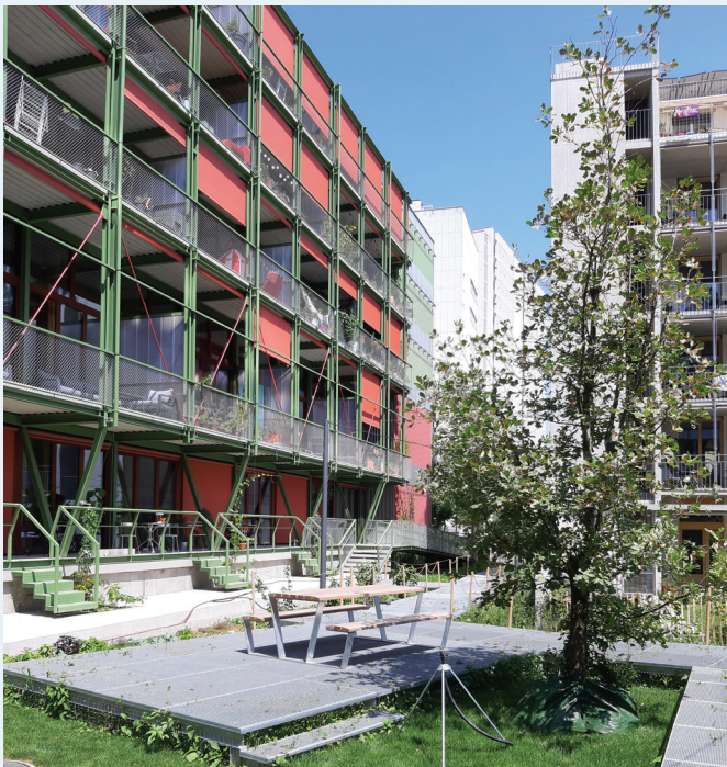
3. „Balkonregale“ ehem. Weinlager, Lysbüchel Basel Esch Sintzel Architekten, Zürich
