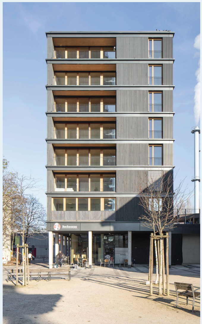
Gewerbe in der Erdgeschosszone Bugginger Straße 52, Weingarten Freiburg Weissenrieder Architekten, Freiburg
