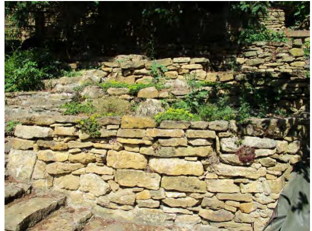
Abb. 8: Trockenmauer in einem Kleingarten im westlichen Teil
