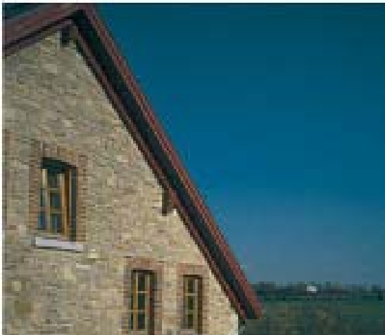
Bruchsteinmauerwerk
