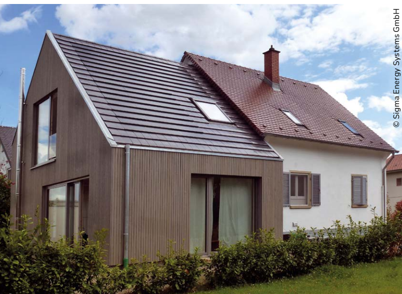
Photovoltaik als Dachintegration
