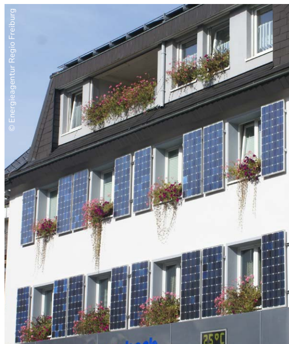
Photovoltaik an der Fassade
