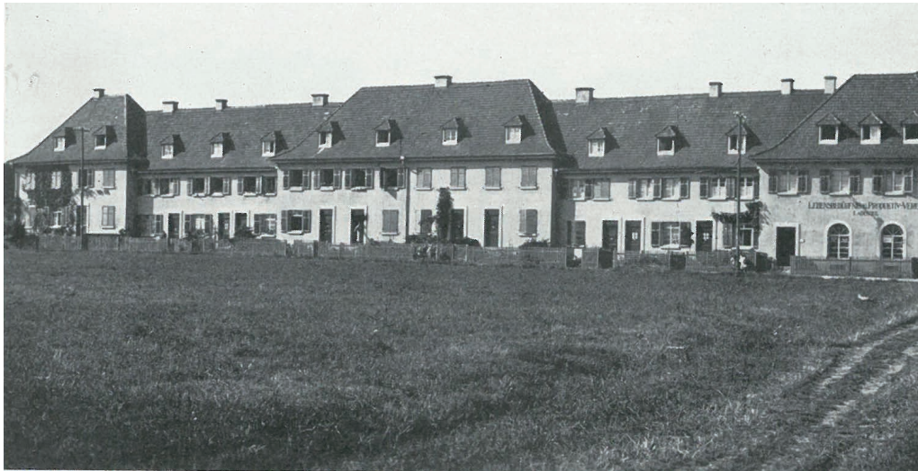
Historische Aufnahme: Häuserblock an der Gutleutstraße zwischen Körner- und Bauhöferstraße
