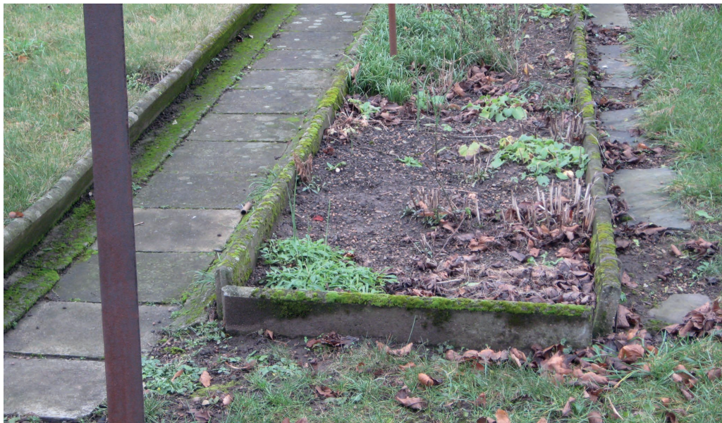
Historisches Beispiel für Betonplatten und Einfassung von Beeten mit gerundeten Betonkantsteinen
