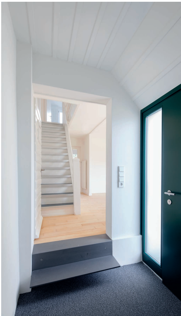
Windfang mit neuer Treppenstufe aus Stahl
