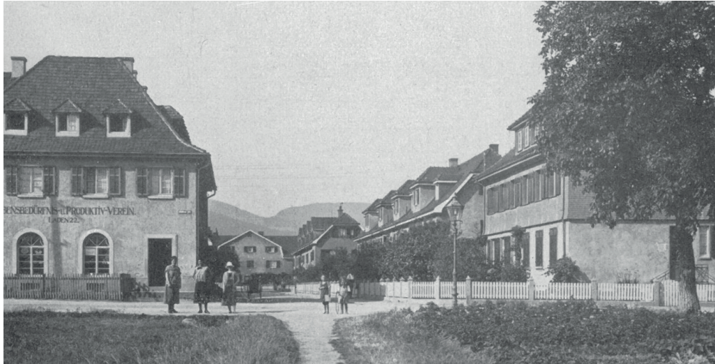
Historische Aufnahme Eingang Körnerstraße
