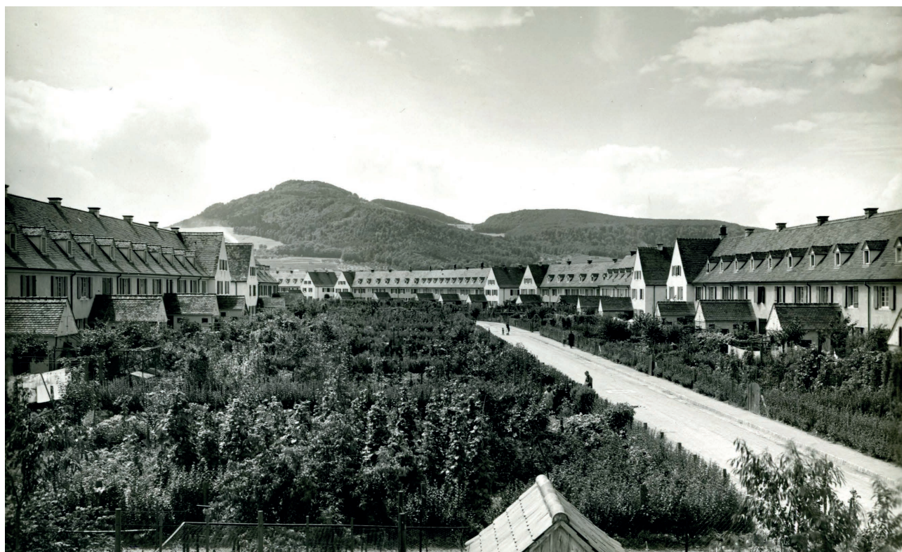
Historische Aufnahme, Bauhöferstraße, Blick zum Schönberg
