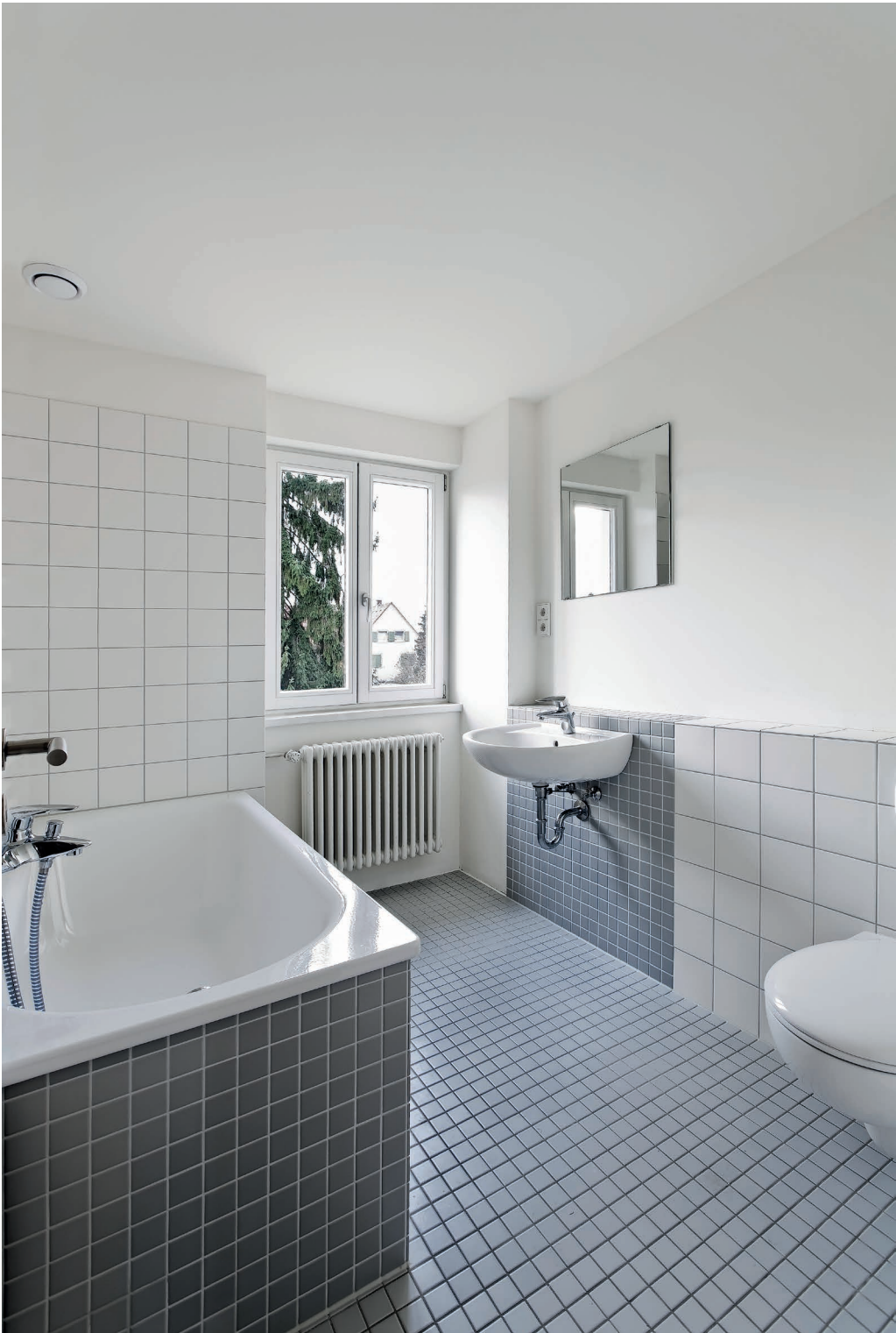
Neues Bad im OG nach Fertigstellung
