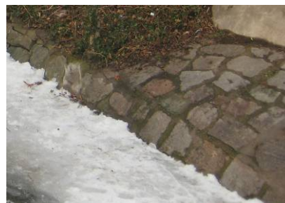
verbauter Böschungsfuß (Brücke an der Markgrafenstraße)
