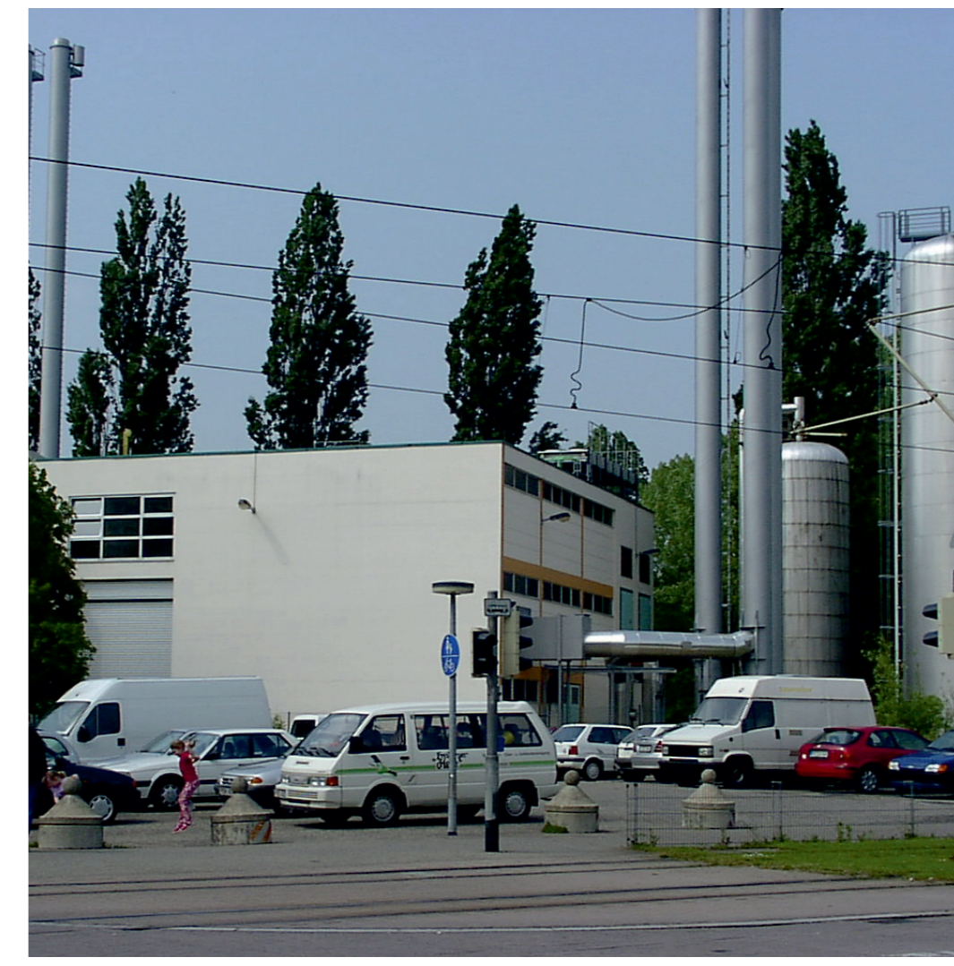
Heilz Kraftwerk vor der Umgestaltung
