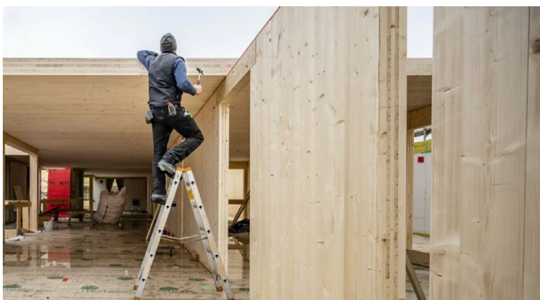
Abb. 15: Beispiel Holzbau, Errichtungsphase
