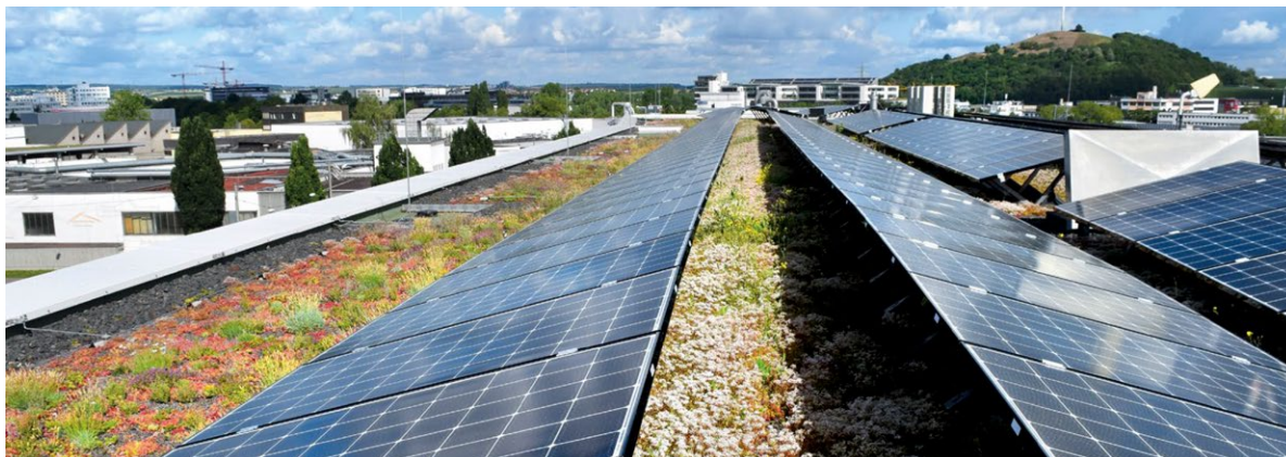
Abb. 2: Photovoltaik-Anlage auf begrüntem Dach
