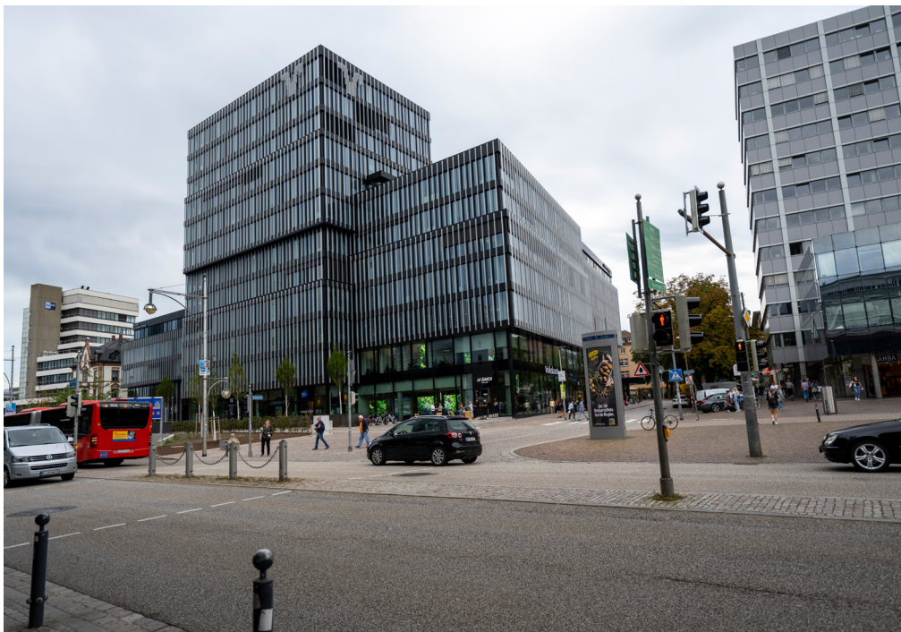
Abb. 21: Blick vom Bahnhof in die Eisenbahnstraße [Quelle: Stadt Freiburg, Patrick Seeger]
