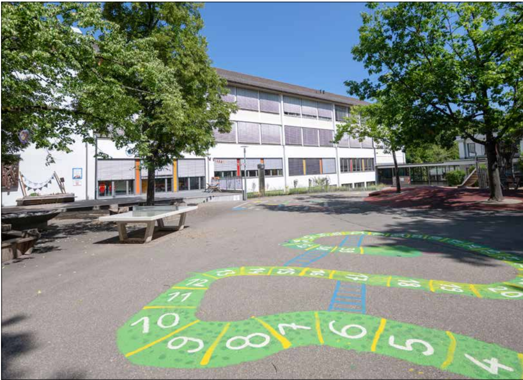
Update in Sicht: Aus dem verschlungenen Sanierungspfad soll ein kerzengerader werden. Der 50er-Jahre-Anbau der Reinhold-Schneider-Schule hat es bitter nötig.
