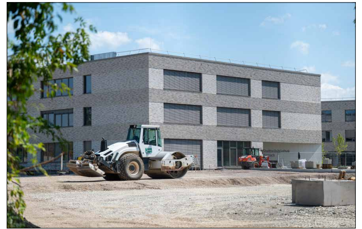
Viel zu tun: Die Staudinger-Gesamtschule bekommt eine neue Außenanlage. Bis zum Frühjahr 2027 soll alles fertig werden.
