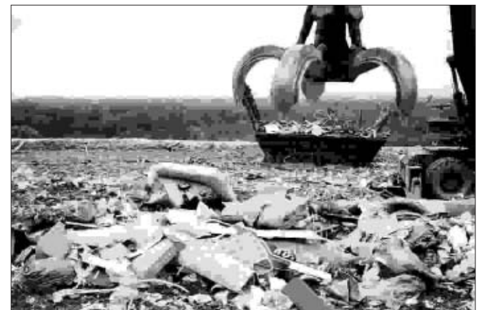
Freiburgs Deponie Eichelbeck hat ausgedient – der Müll wird jetzt in der TREA im Gewerbepark Breisgau bei Eschbach verbrannt (Foto: R. Buhl)
