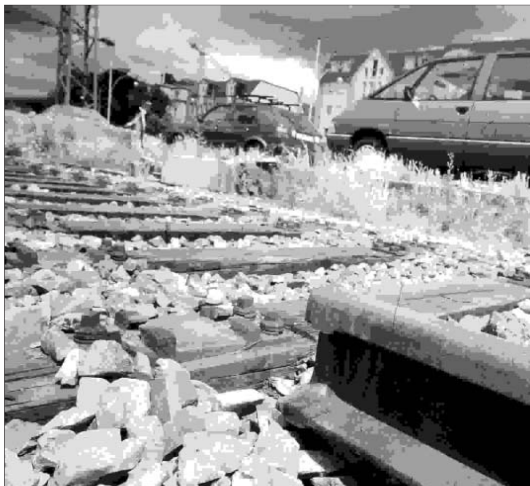
Der Ausbau des Stadtbahnnetzes soll weitergehen – wegen der schlechten Haushaltslage jedoch langsamer als ursprünglich geplant (Foto: R. Buhl)
