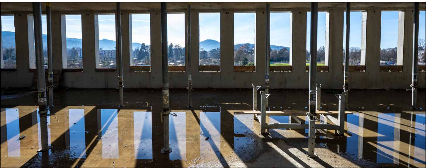
Cool – von außen wie von innen: Neben der roten Hauptfeuerwache (im Foto oben rechts) in der Eschholzstraße entsteht das neue Rettungszentrum. Für den zweiten Bauabschnitt wurde kürzlich das Richtfest gefeiert.
