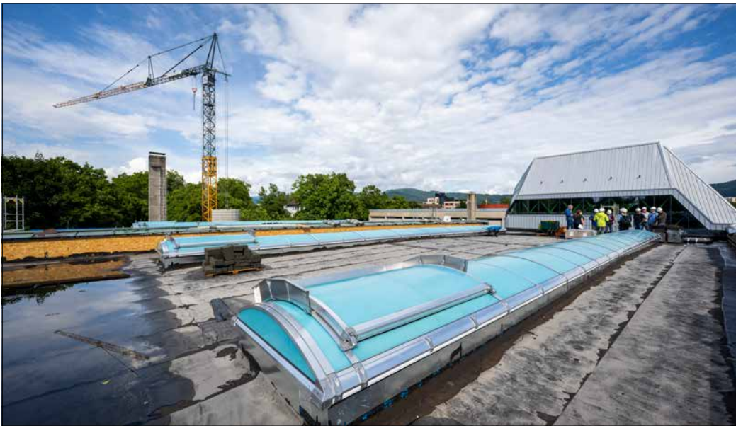
Neu und dicht: Die Lichtschächte auf dem Dach der Wentzinger-Sporthalle sorgen künftig nur noch für Helligkeit in der Halle – Wasser bleibt ab sofort außen vor.
