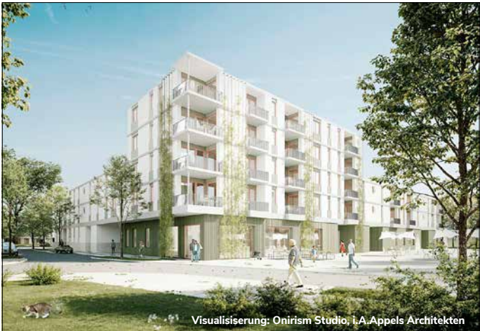
Mehr Wohnraum für Lehen: Auf dem Grundstück „Zink 6“ baut die FSB 70, auf „Zink 1“ circa 60 Wohnungen.
