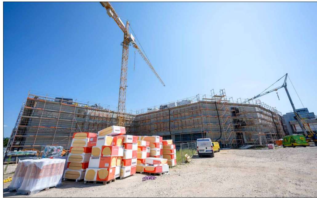
Neubau der Stadingerschule: Das 100-Millionen-Euro-Projekt ist eigentlich keine klassische Sommerbaustelle, aber natürlich geht es hier auch in den kommenden Wochen rund.
