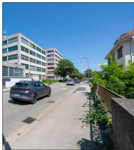
Fast unsichtbar: Die Rossgässlebachbrücke ist so marode, dass sie ersetzt werden muss.
