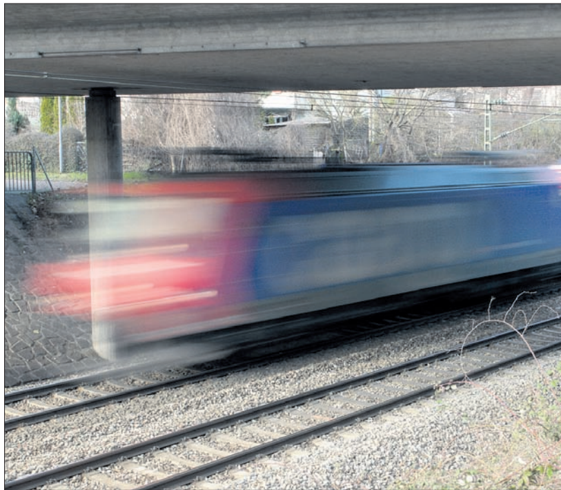
Die Ausbaustrecke entlang der Autobahn bringt Entlastung für die Anwohnerschaft der bisherigen Güterbahnstrecke...
