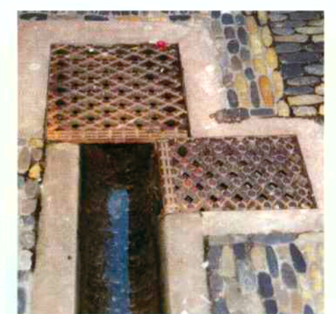
Augustinerstraße, Einlauf und Überlauf
