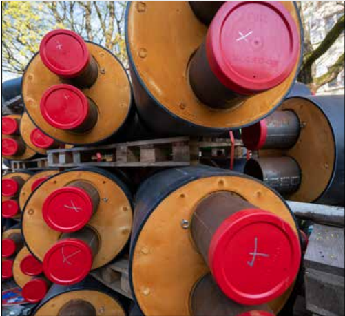
Dicke Dinger: Fernwärmeleitungen lassen sich nicht minimalinvasiv im Boden versenken.
