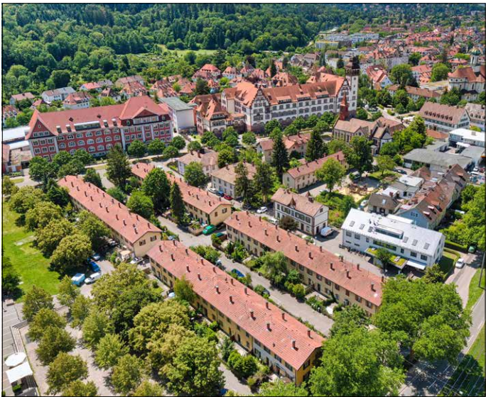
Städtebauliches Juwel: Die Sanierungsarbeiten in der Knopfhäusle-Siedlung sind weit fortgeschritten. (Foto: J. Raiber)
