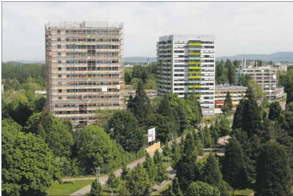
Wegweisende Nachbarn: Rechts das bundesweit erste Altbau-Passivhochhaus „Buggi 50“, links das fast fertig gestellte zweite Im Binzengrün 9. Ab November ziehen dort die Mieter in die 105 Wohnungen. (alle Fotos: A. J. Schmidt)
