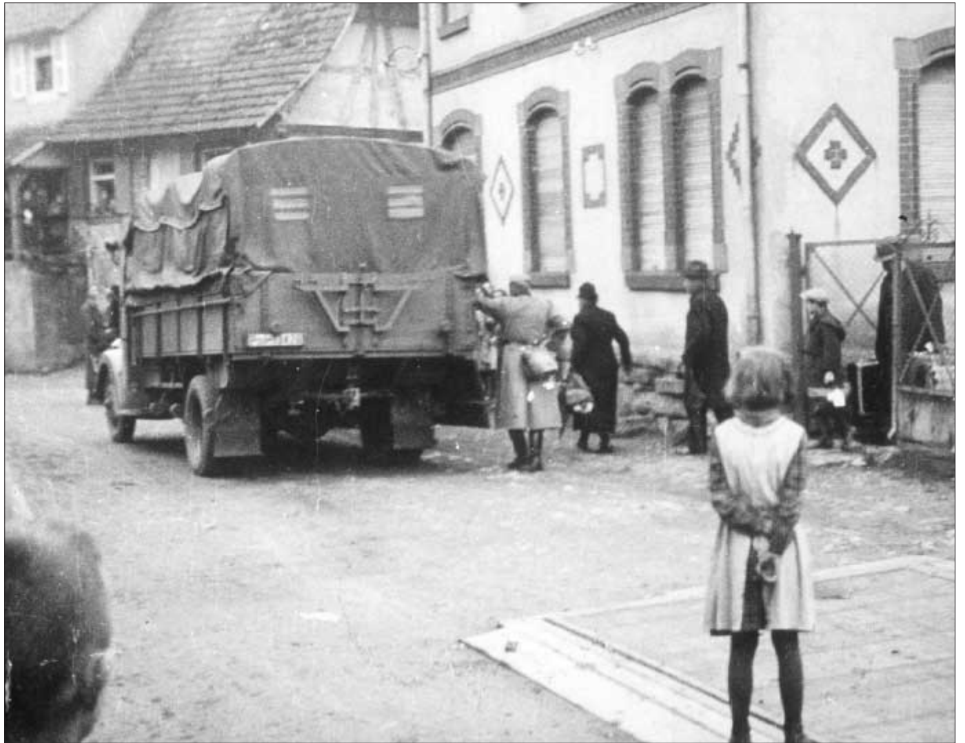
Eins der wenigen existierenden Bilder von der Deportation der Juden in Baden zeigt den Abtransport der Familie Maier am 22. Oktober 1940 aus der Querstraße in Kippenheim (südlich von Lahr). Die Familie hatte das Glück, das Lager zu überleben und in die USA zu gelangen. Zwischen den Pfosten des Hoftors ist der 10-jährige Kurt Maier zu sehen, der wie Hedy Epstein, Inge Auerbacher, Paul Niedermann, Amira Gezow, Renate Haberer-Krauss, Richard Levi und anderen als Zeitzeuge im Rahmen des Ausstellungsprojekts „Die Deportation nach Gurs 1940“ in der Katholischen Akademie zu Gast sein wird. (Foto: Privat)
