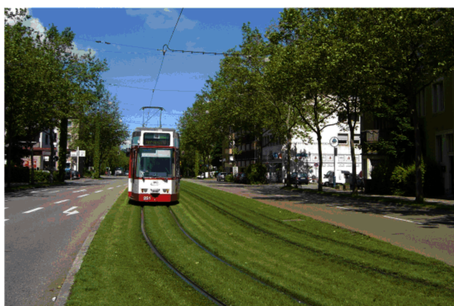
Die neue Stadtbahnstrecke wird zum großen Teil als Rasengleis angelegt, das neben den neu gepflanzten Bäumen auch zur Begrünung der neu entstehenden Straßenräume beiträgt.
