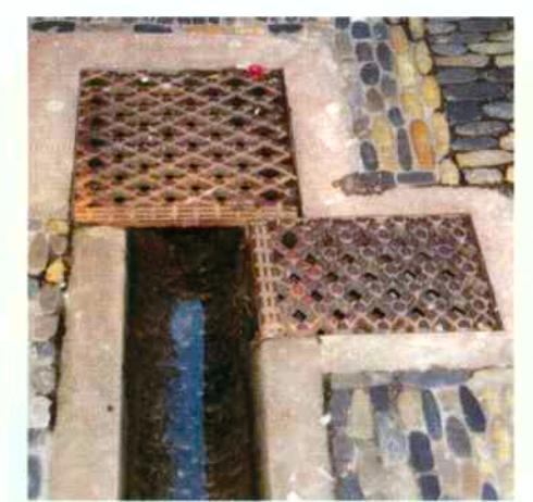
Augustinerstraße, Einlauf und Überlauf
