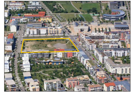
Luftbild mit Markierung des Baubereiches, 2009
