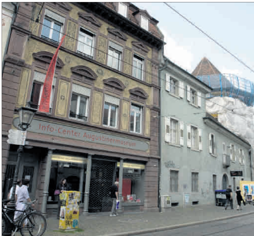
Das seit 2003 im städtischen Besitz befindliche Gebäude Salzstraße 34, in dem sich heute das Info-Center des Museums befindet, soll für das Augustinermuseum genutzt werden. Unter anderem können hier das Stadtgeschichtliche Museum und ein Museumsshop Platz finden. (Foto: R. Buhl)
