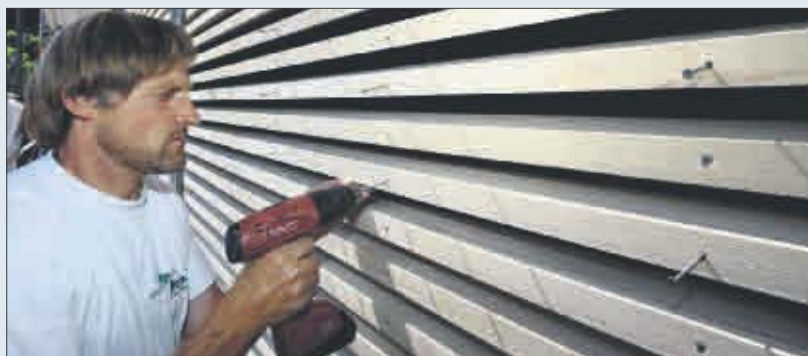
Holzbau in Rekordzeit: Nur sieben Monate vergingen zwischen Grundsteinlegung und Eröffnung (Foto: K. Echle)
