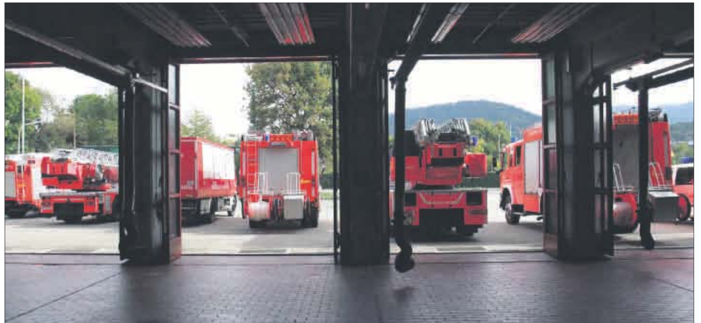
Umfassend saniert wird bis 2012 auch die Hauptfeuerwache in der Eschholzstraße.
