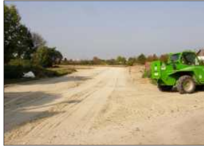
Innere Elben während der Erschließungsarbeiten, 2007
