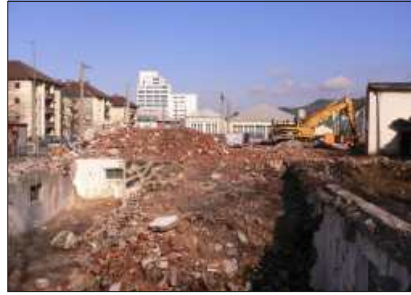
Komturstraße während des Abrisses, 2007
