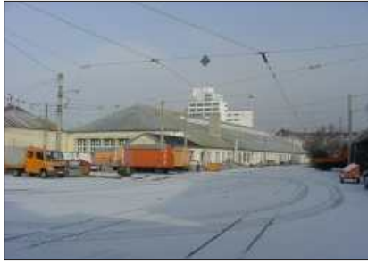
Komturstraße, 2006 vor dem Abriss
