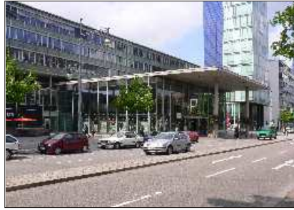
Eingangssituation am Bahnhof
