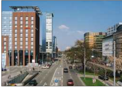
Bahnhofsachse mit Photovoltaikanlage am Bahnhofsturm
