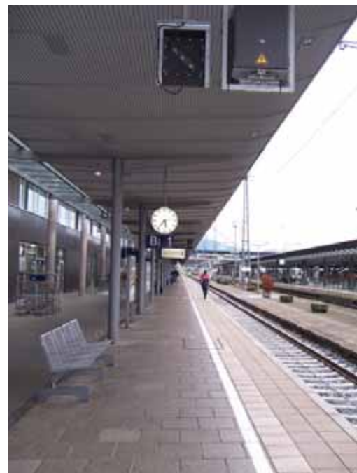
Bahnsteig nach dem Umbau
