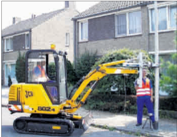
Wenn der Mast dem Bagger standhält, dann hält er auch dem Alltag stand (Foto: Badenova)
