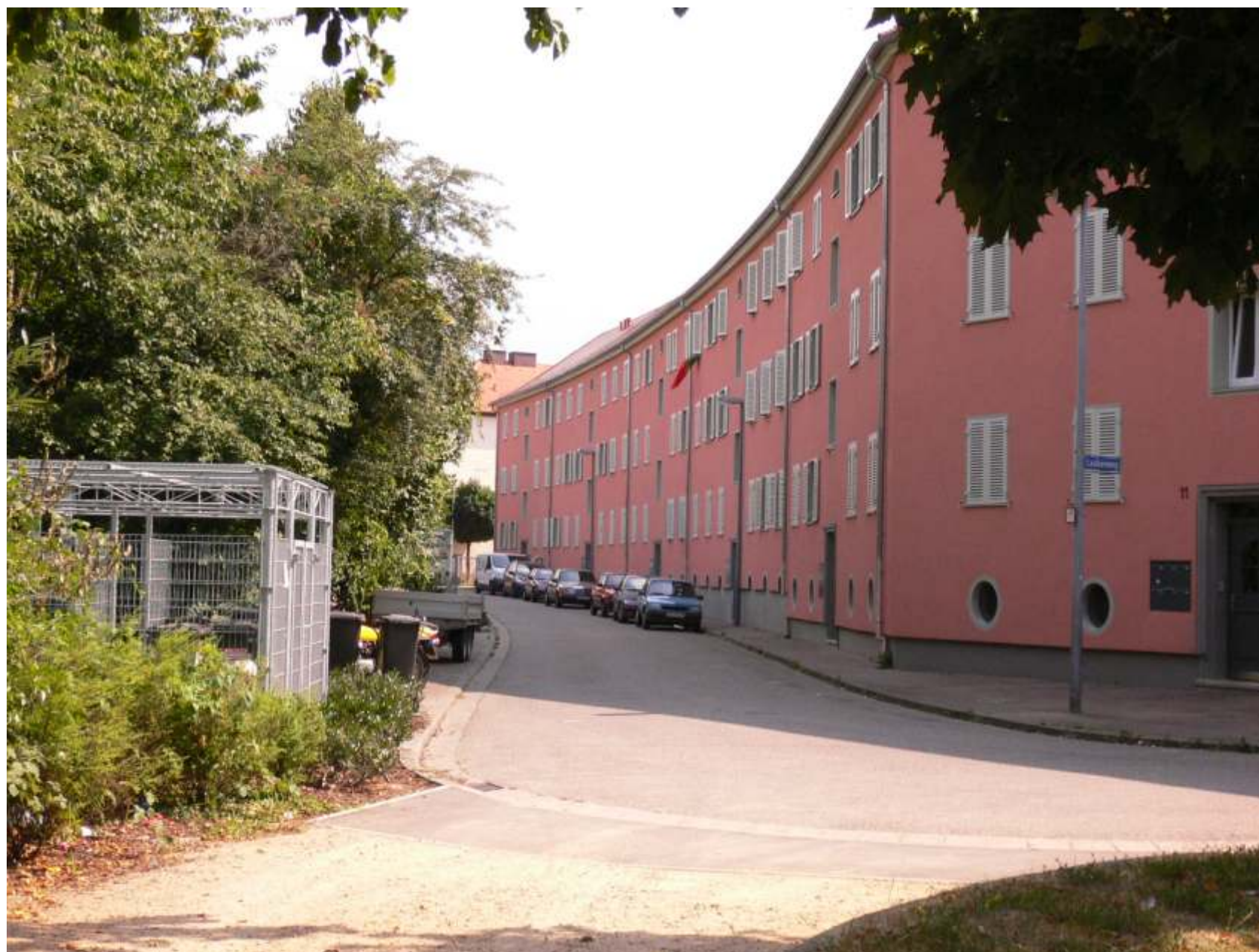
Nonnenmattenweg nach der Modernisierung, Straßenseite, 2006
