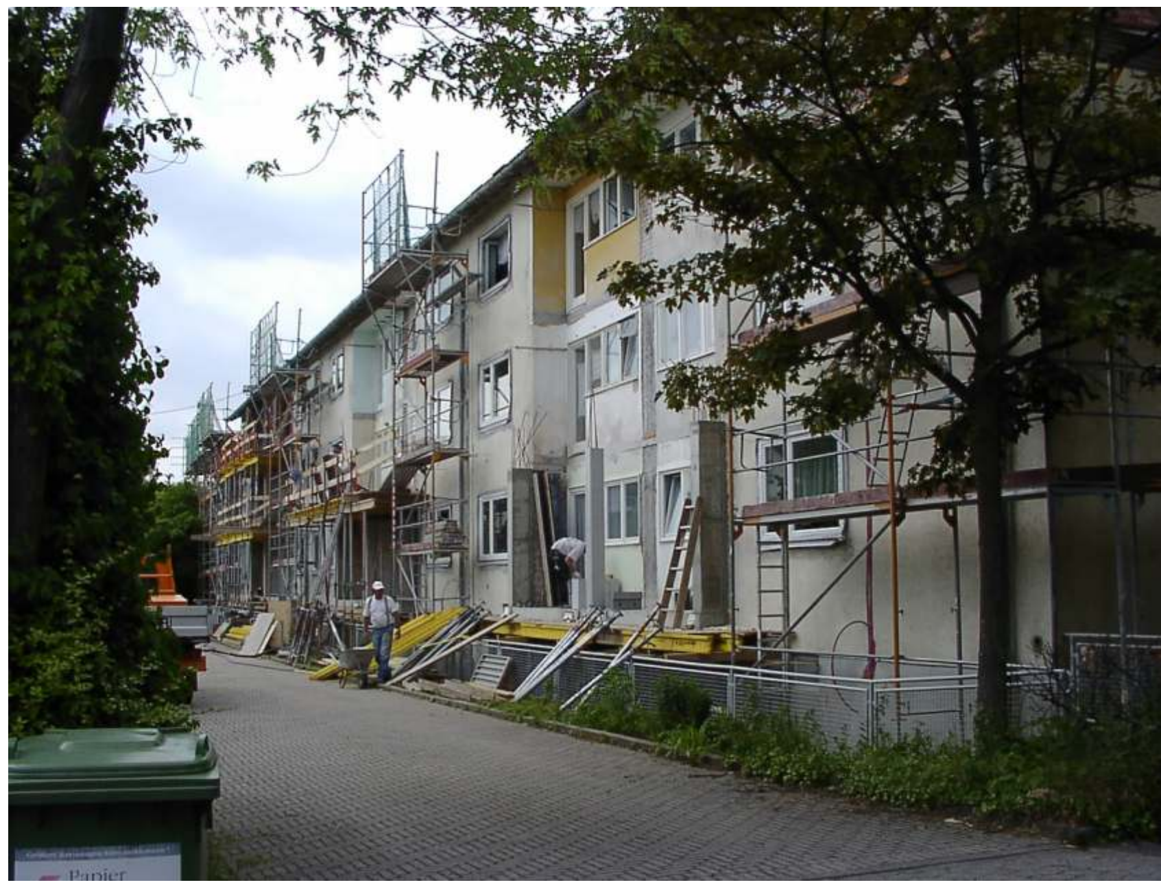
Rislerstraße während der Modernisierung, 2004
