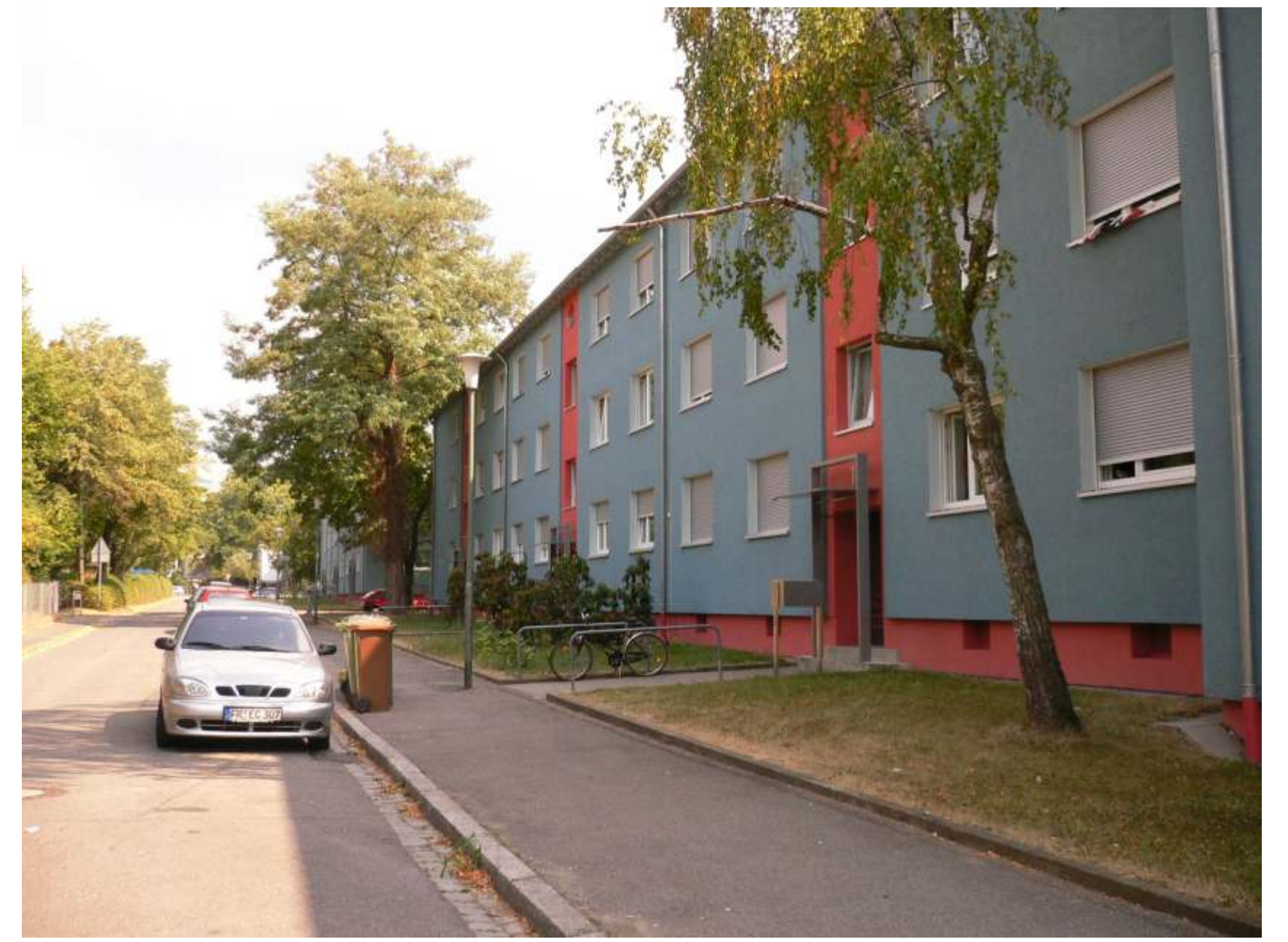
Rislerstraße während der Modernisierung, 2006
