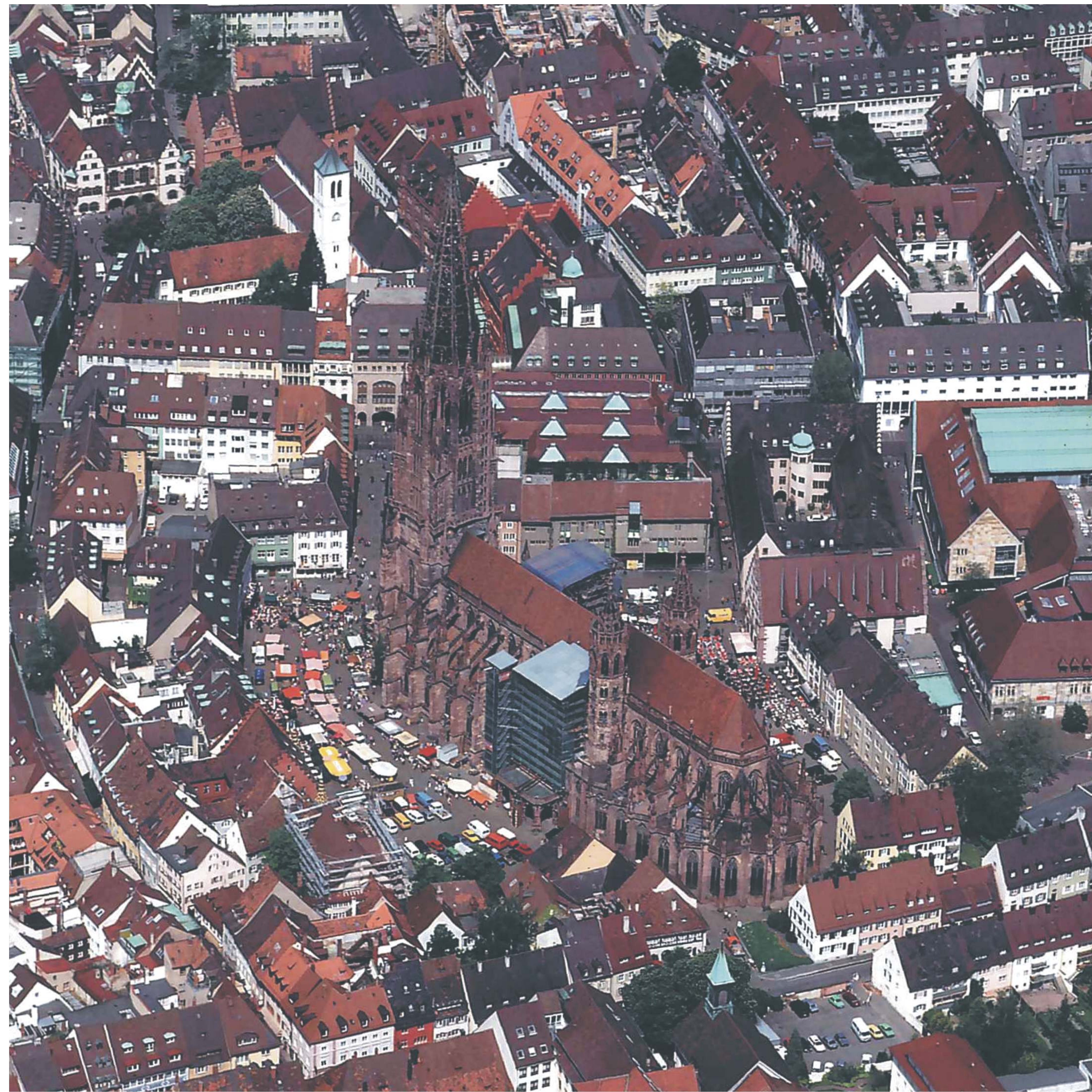
Münsterplatz aus der Luft - Aerial view of Münsterplatz Foto: Elsevier/Lutbild GmbH, Stuttgart
