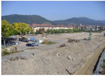
Baubeginn, Blick Richtung Nordosten, 10 / 2005
