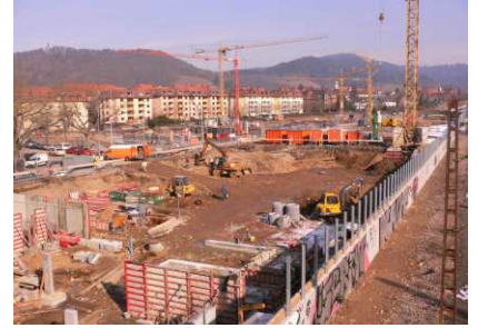
Baufortschritt, Blick Richtung Nordosten, 2 / 2006
