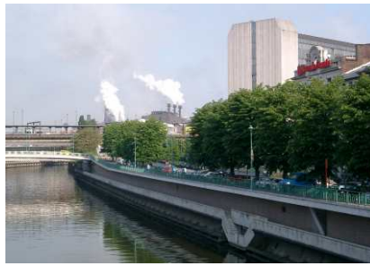
Belgien - Stadtbau am Fluss Charleroi
