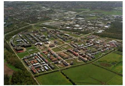
Luftbild: M. Meyer, Hasel, Blick nach Südosten, 2005
