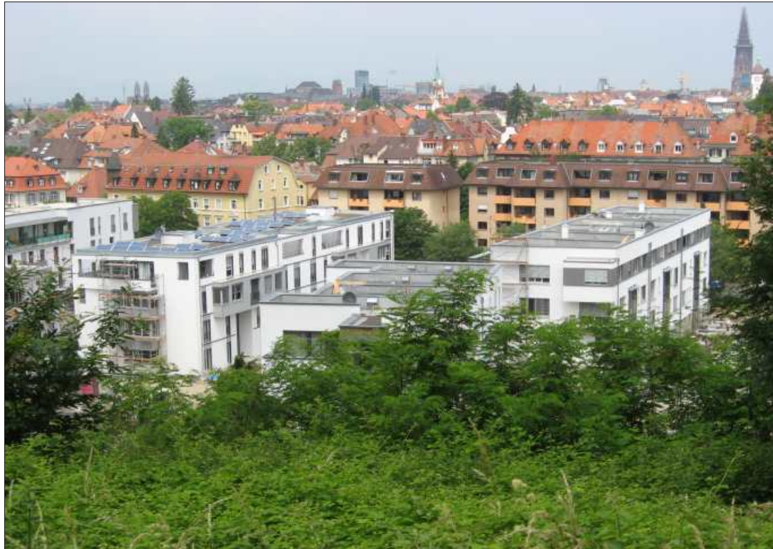
Blick auf das Baugebiet am Wiehrebahnhof
